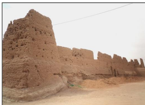
Figure 14: Soubassement des murs porteurs à Aoulef (source: Bakhti & Sadi, 2008).
