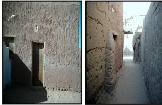
Figure 15: Tibak et Etesbagh des murs extérieurs (source: auteur, 2009).
